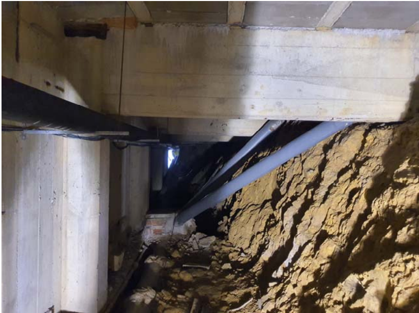
Foto 7: Foto de la viga 6
