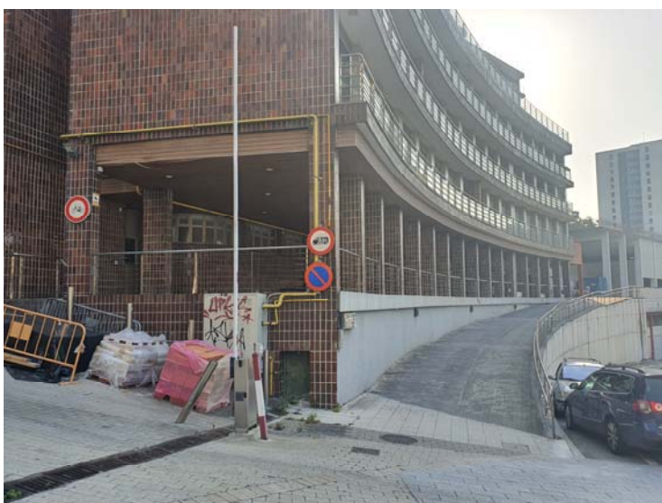
Imagen 5: Vista de la rampa de acceso y porche de planta baja del Centro Egogain
