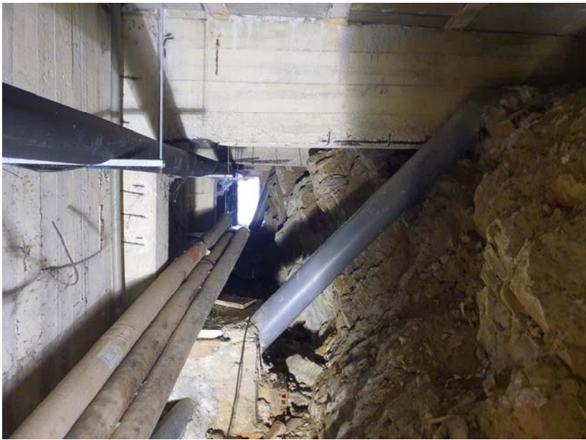
Foto 5: Foto de la viga 4
