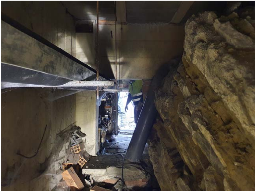
Foto 3: Foto de la viga 2
