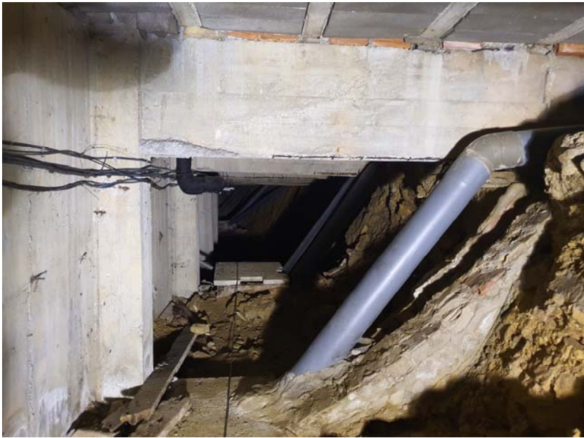
Foto 11: Foto de la viga 10
