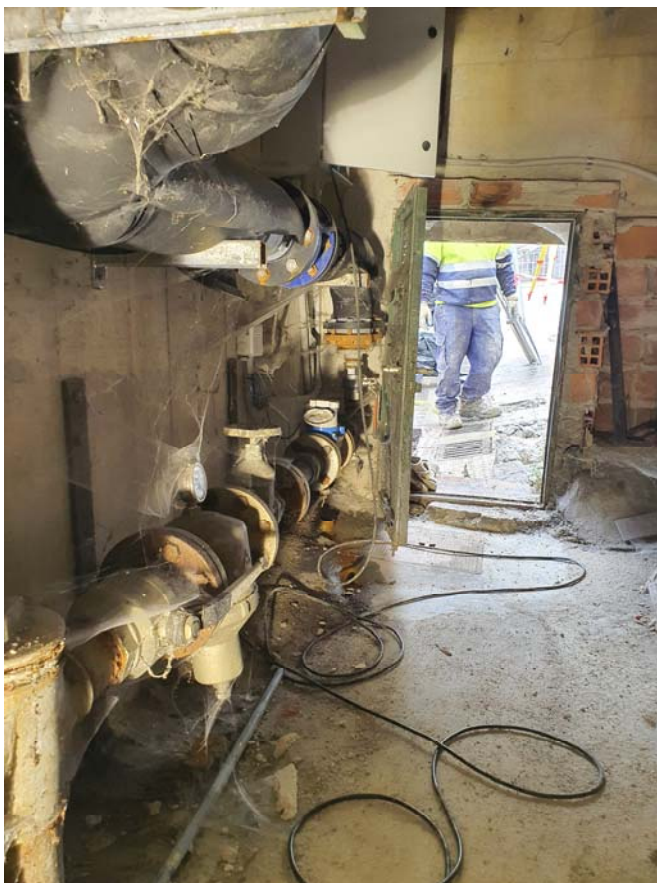
Imagen 1: Vista del acceso a sótano, con el abastecimiento de agua potable a la izquierda
