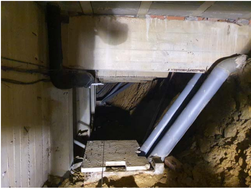
Foto 10: Foto de la viga 9
