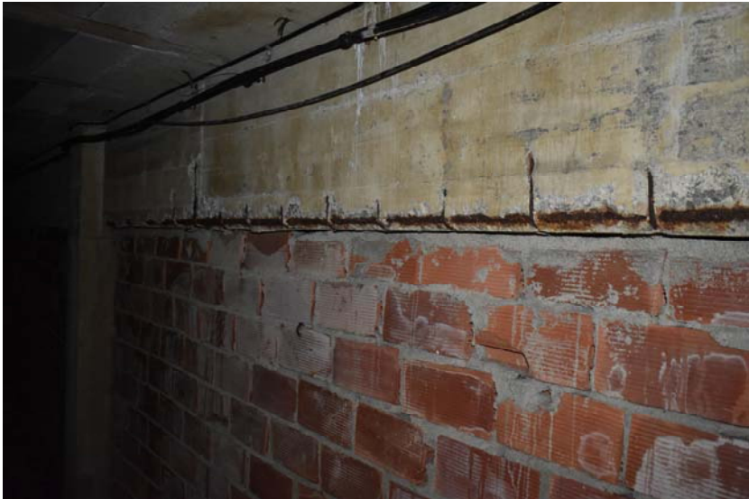
Foto 18: Foto de la viga 17
