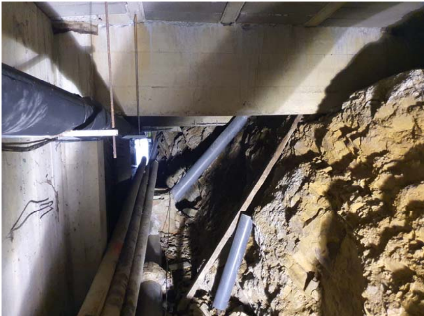
Foto 6: Foto de la viga 5
