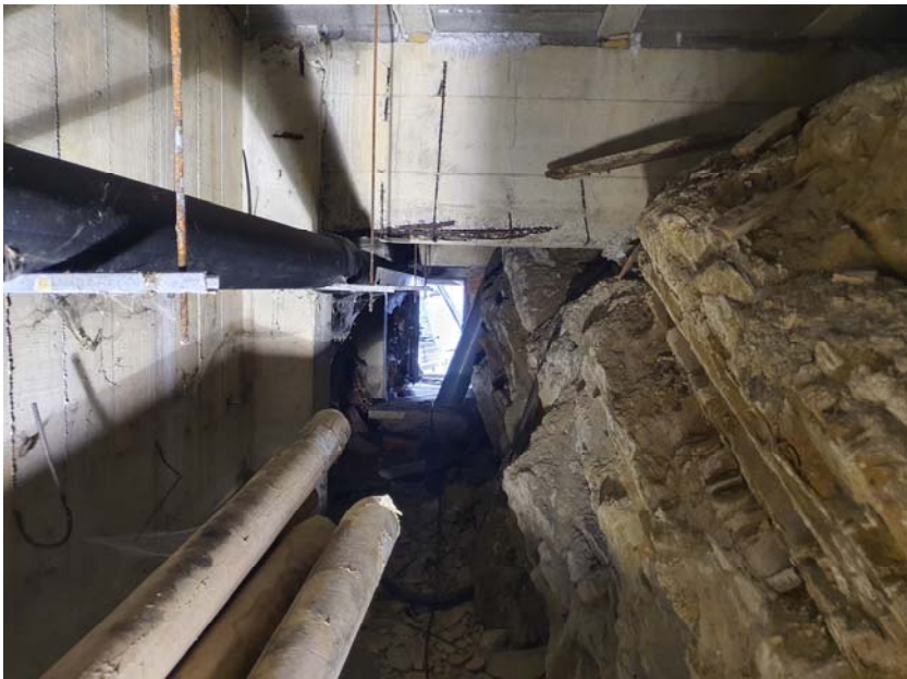
Foto 4: Foto de la viga 3
