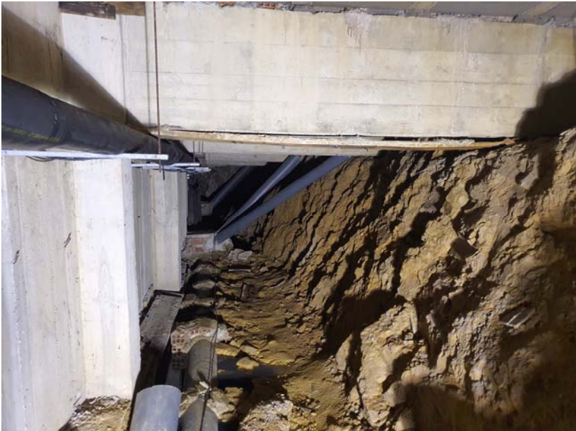
Foto 8: Foto de la viga 7
