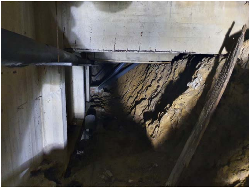
Foto 9: Foto de la viga 8
