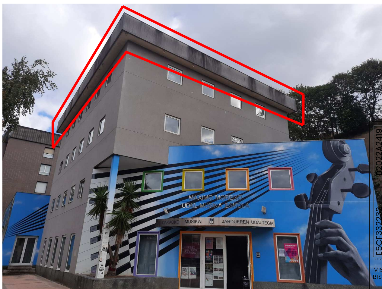
ESTADO ACTUAL DEL EDIFICIO _ ZONA DE ACTUACIÓN
