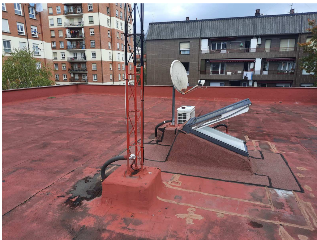
ESTADO ACTUAL DE LA CUBIERTA
