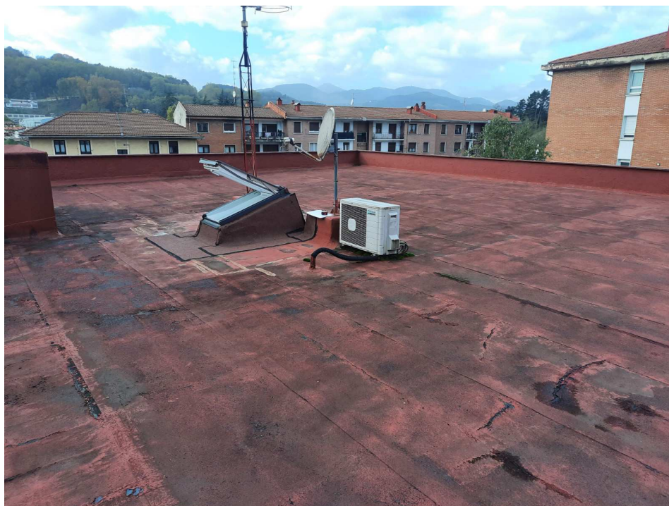
ESTADO ACTUAL DE LA CUBIERTA
