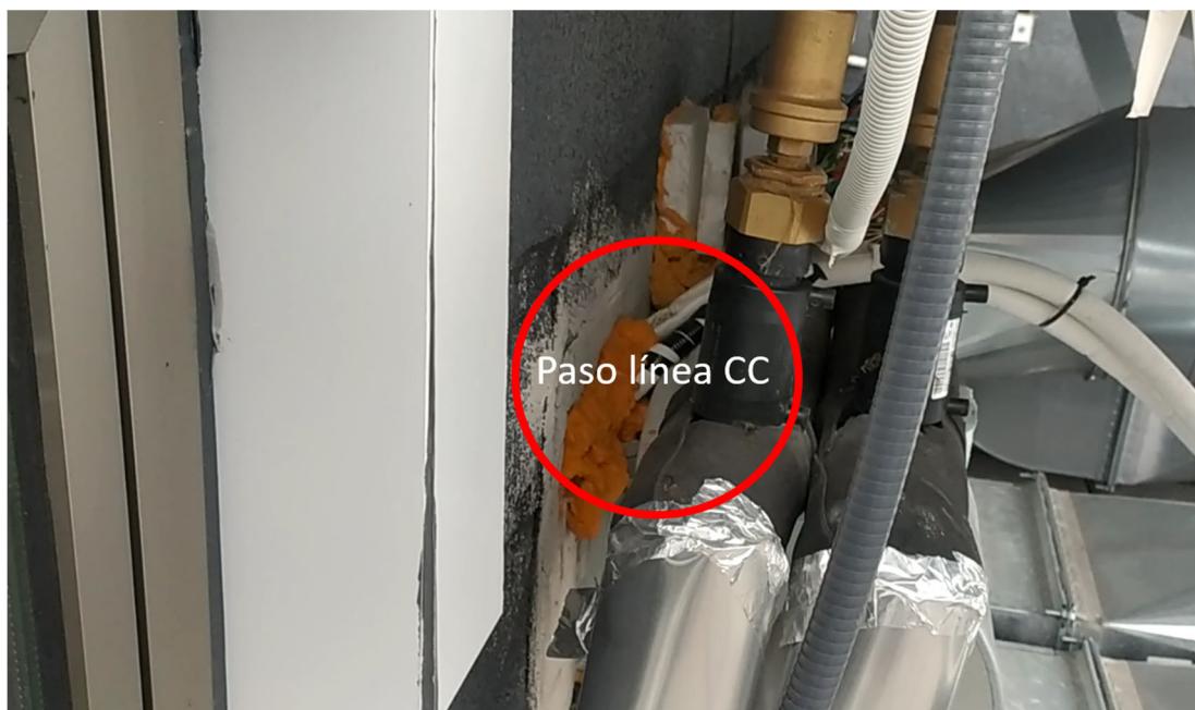
Paso desde el exterior al interior
