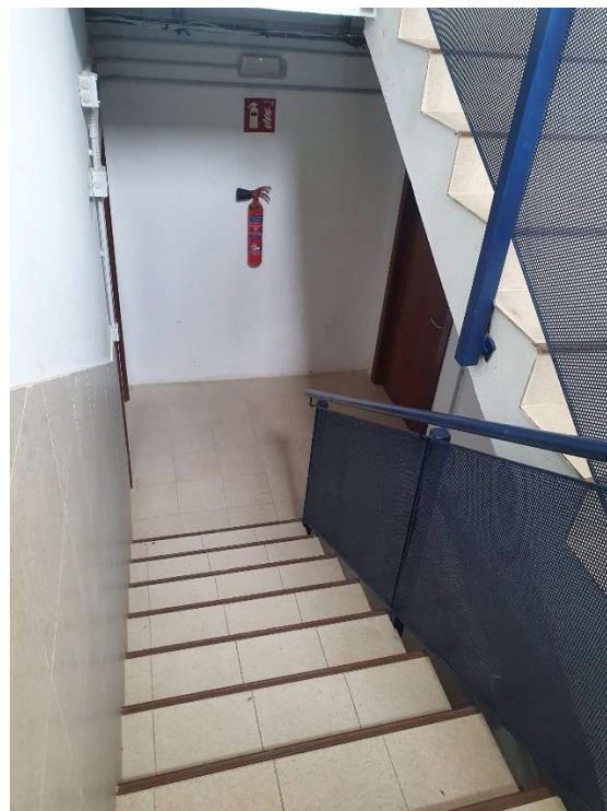
4.- 2º BLOQUE ESCALERAS DE ACCESO A SOTANO
