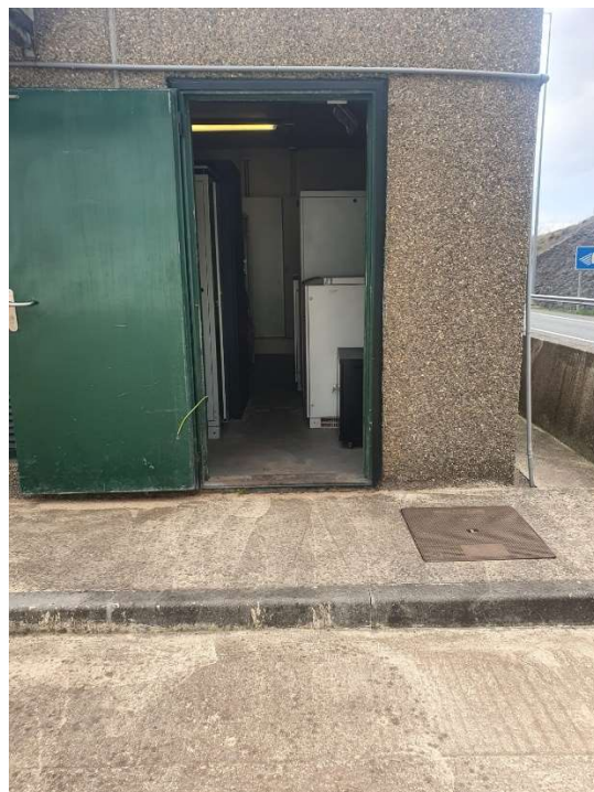
2.- ACCESO AL CUARTO
