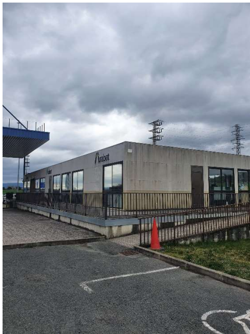
1-RAMPA EXTERIOR DE ACCESO AL EDIFICIO
