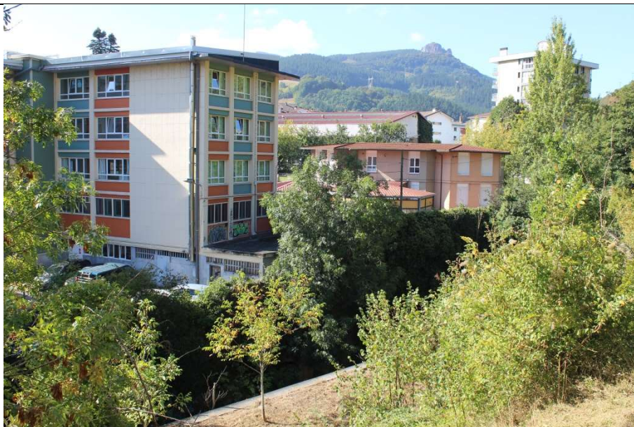
Luis Ezeiza (fachada trasera y lateral 2)
