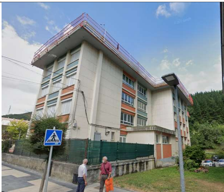
Luis Ezeiza (fachada lateral 1 y trasera)
