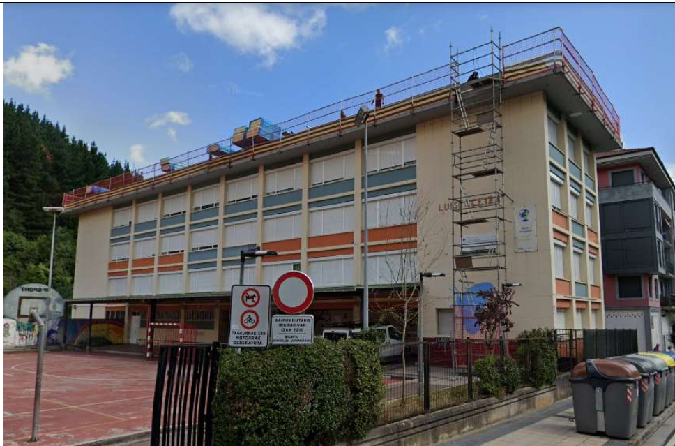
Luis Ezeiza (fachada principal)
