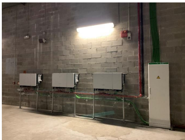
Ubicación Grupo 1 Inversores + CP Fotovoltaica G1
