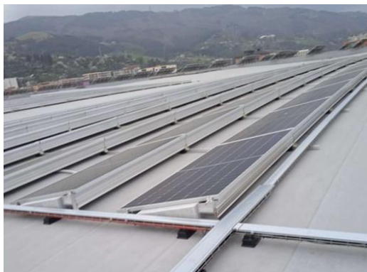
Canalización de conductores CC y CA
