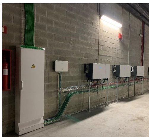
Ubicación Grupo 2 Inversores + CP Fotovoltaica G2
