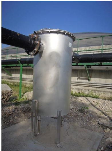
Ilustración 28. Trampa de condensados
