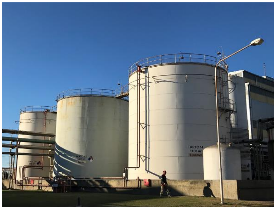
Ilustración 16. Instalación digestores techo rígido
