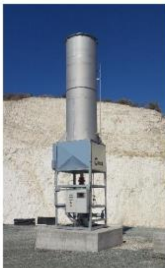
Ilustración 30. Antorcha de llama confinada
