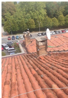
CUBIERTA DE TEJA ARABE
