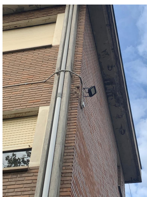
DESCONCHADO DE FACHADA
