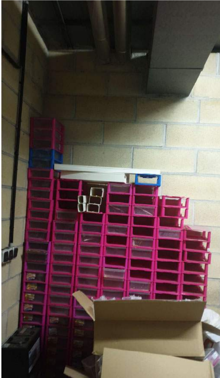
Zona de instalación AC/DC
