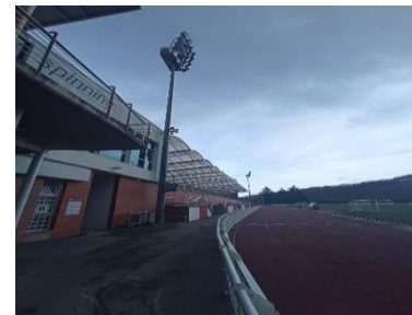
Detalle de los proyectores en torretas
