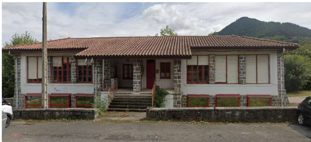
Escaleras de acceso desde aparcamiento
