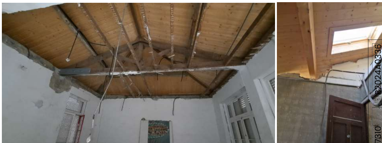
Interior de la cubierta en estado actual
