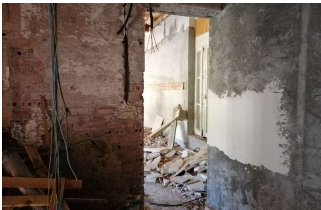
Interiores en estado actual
