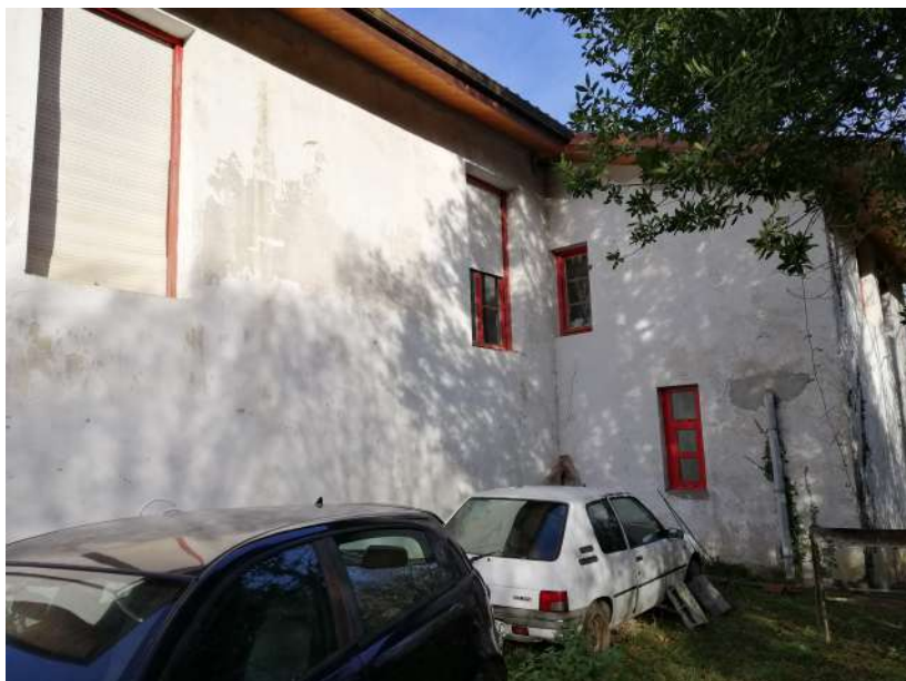
Fachada trasera – ESTE
