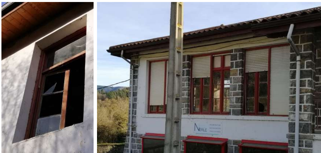
Carpintería exterior en estado actual.
