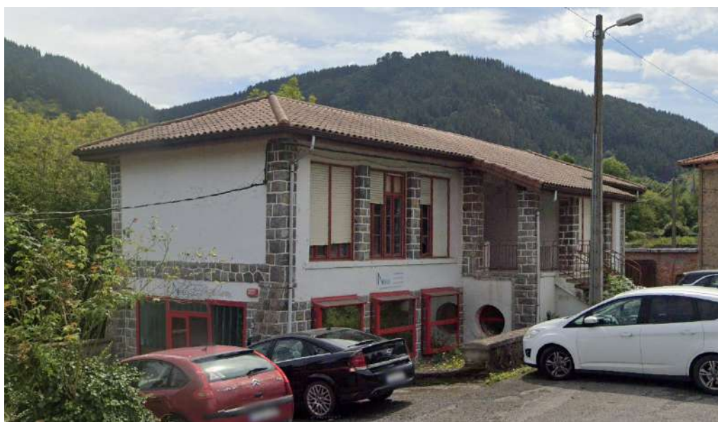
Fachada lateral – NORTE
