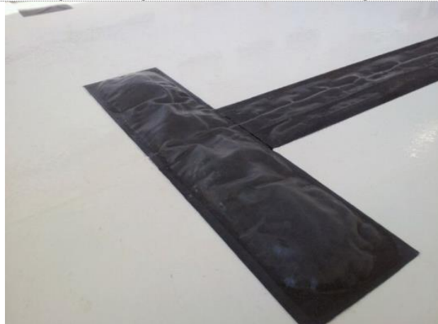
Formación de bolsas de gas cloro generando arrugas y defectos
