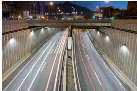
Túnel C-17 Montcada y Reixac, Barcelona - España
