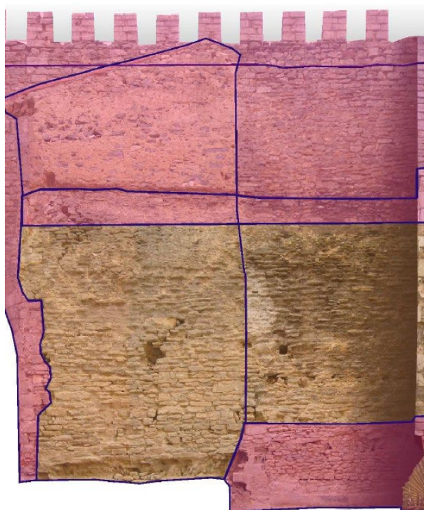
Fotografías 10 y 11: Muralla, alzado Oeste. En amarillo se indican los paños originales del s.XI, y en rosa las intervenciones del s.XX.
