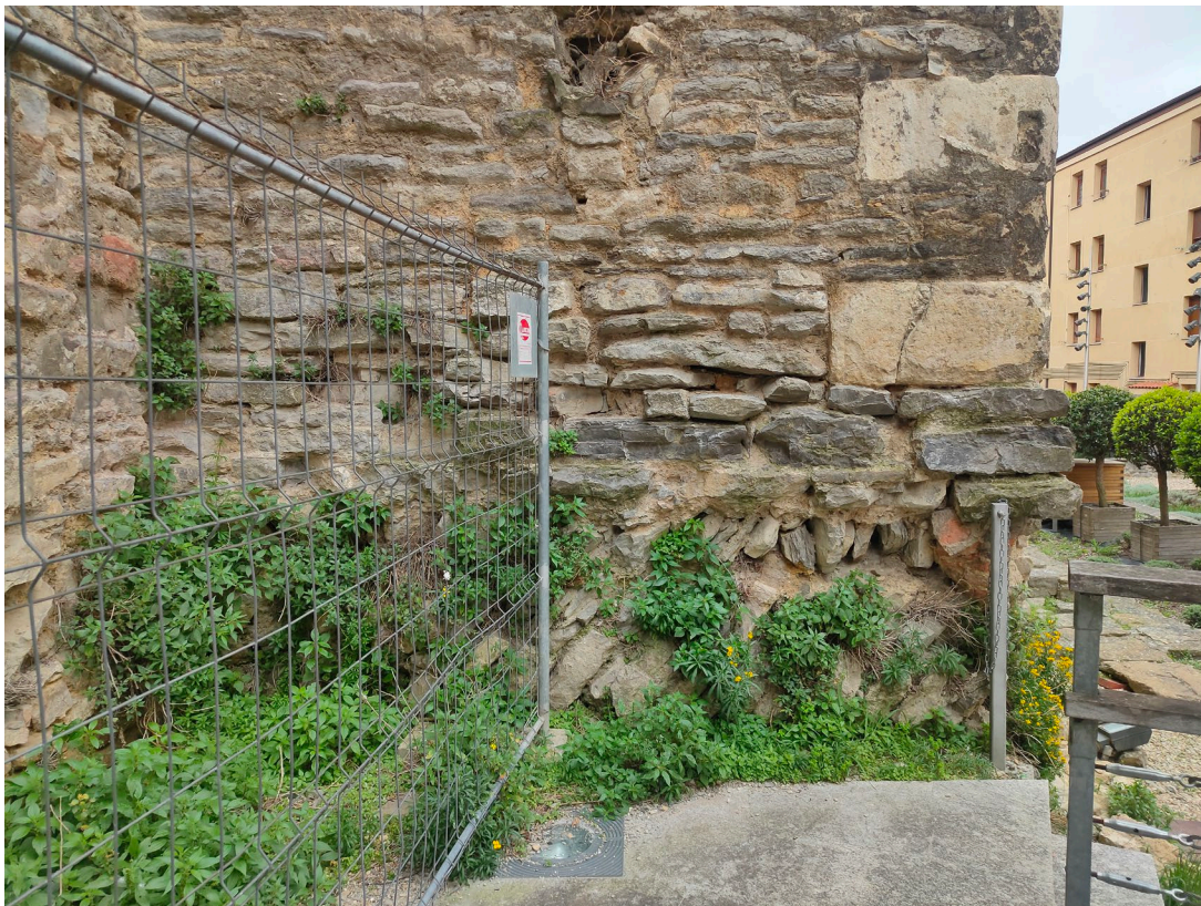
Fotografía 9: Fachada Norte del torreón. Se observa el spicatum y la ausencia de sillarejo en la esquina, (derecha).
