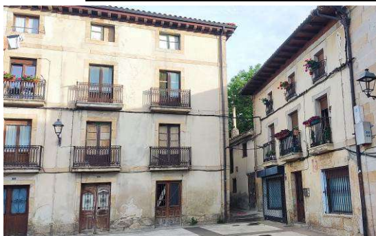
Fachada principal (este)
