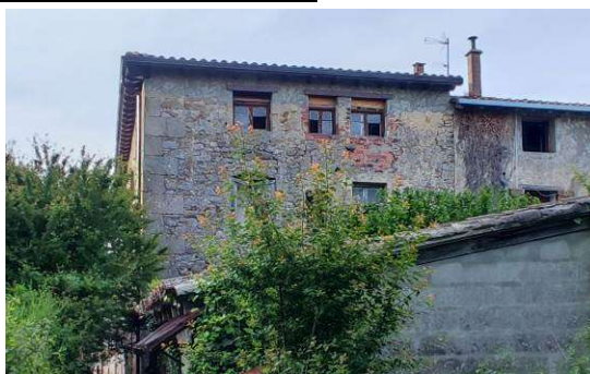
Fachada posterior (oeste)
