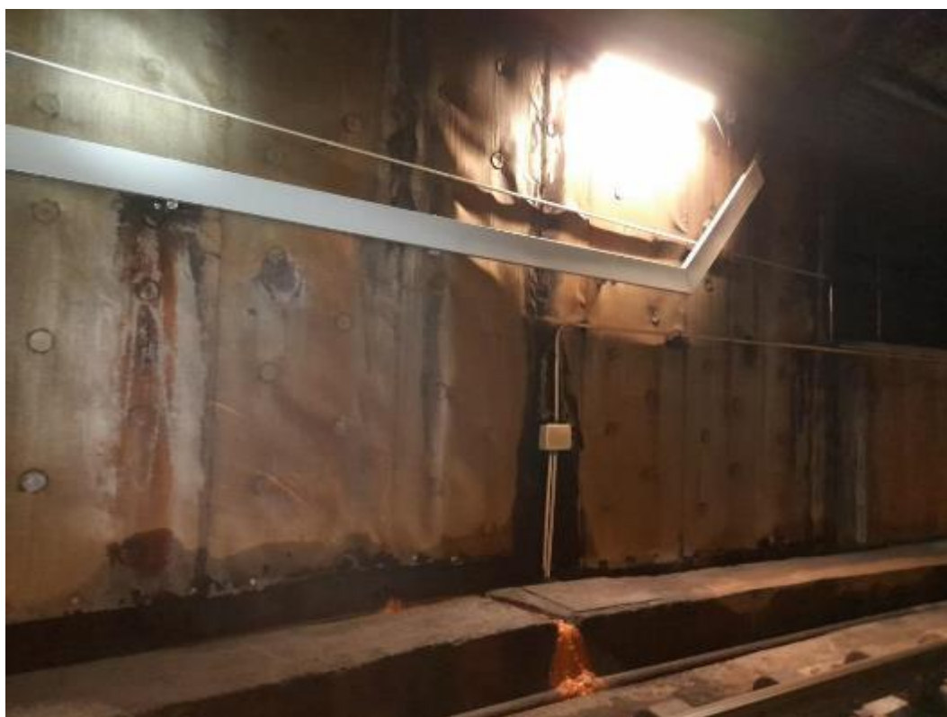
Pk 7/922 Vía 2 Abombamiento de manta
