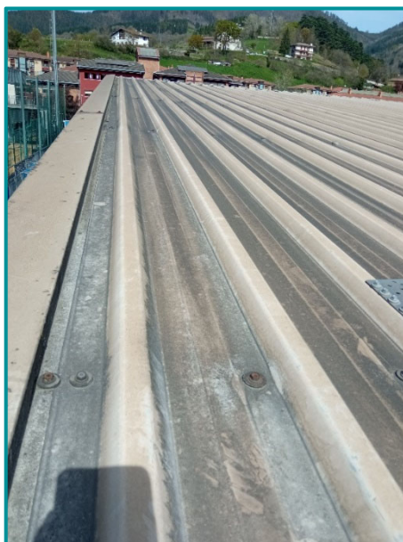
Ilustración 7 Estado de la cubierta desde las escaleras de acceso.
