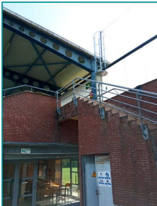
Ilustración 5 La puerta de acceso a la sala eléctrica, y escaleras de acceso a la cubierta.
