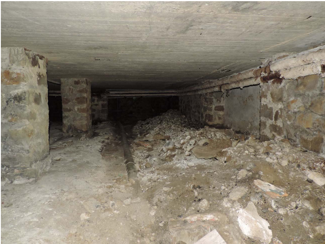
Vista general de espacio de instalacion
