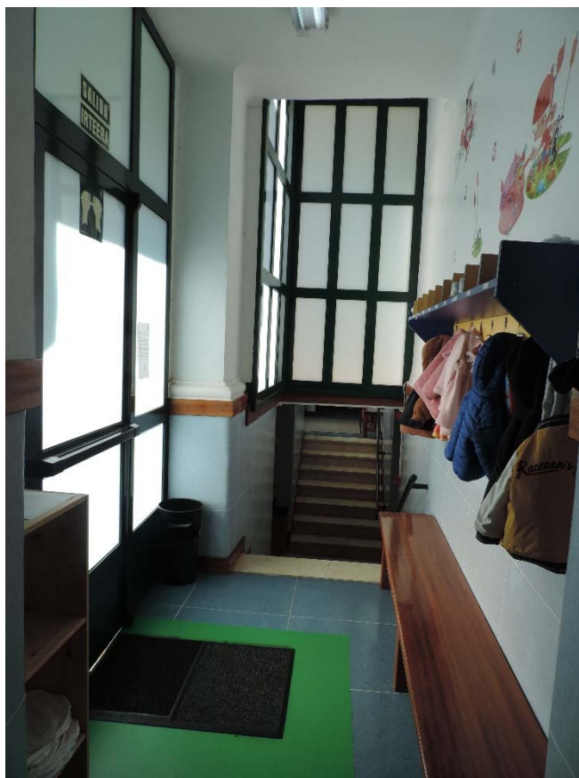
Núcleo vertical del edificio
