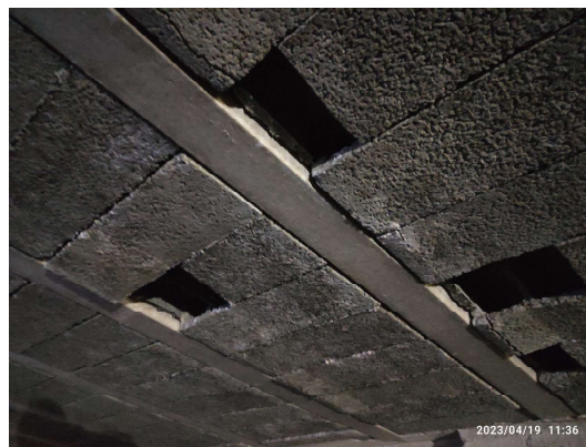
Oxidaciones en armadura de viguetas de forjado (1 cara) y deterioro puntual de bovedillas de hormigón.
