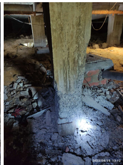
Oxidaciones en armadura de pilares perimetrales (3 caras) e intermedias (4 caras)
