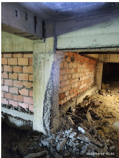
Oxidaciones en armadura de pilares perimetrales (3 caras) e intermedias (4 caras)
