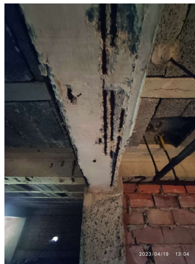
Oxidaciones en armadura de vigas perimetrales (2 caras) e intermedias (3 caras)
