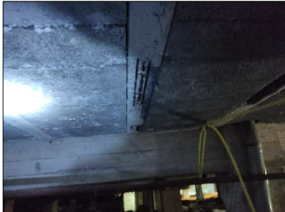
Vigüeta de forjado
