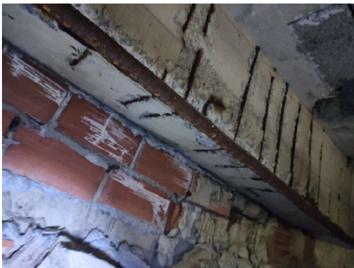
Oxidaciones en armadura de vigas perimetrales (2 caras) e intermedias (3 caras)
