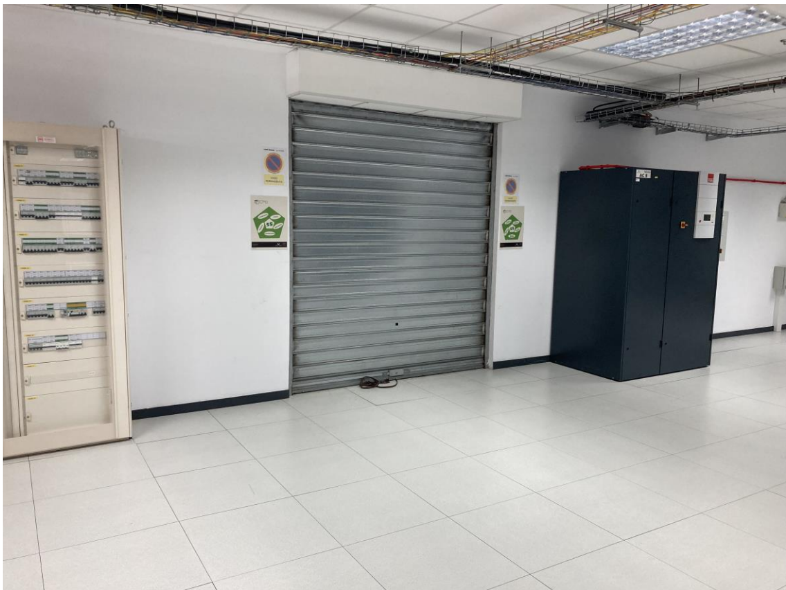
Puerta de carga y muelle (vista desde el interior)
