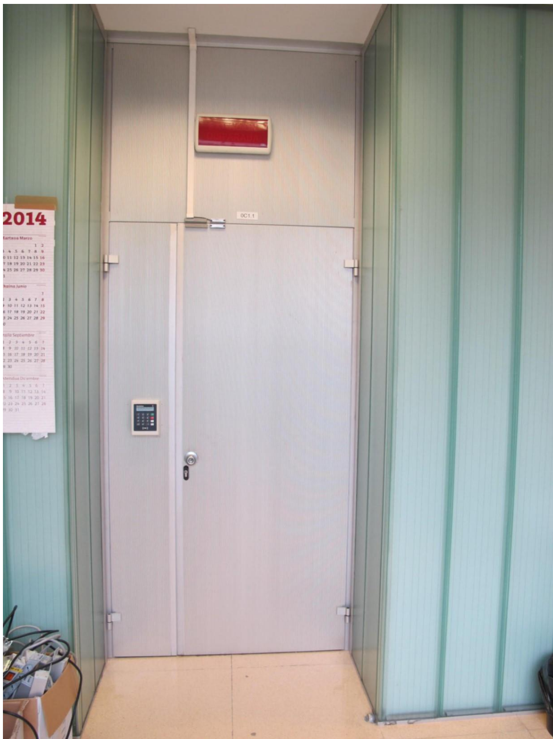
Puerta de entrada a la sala de máquinas
