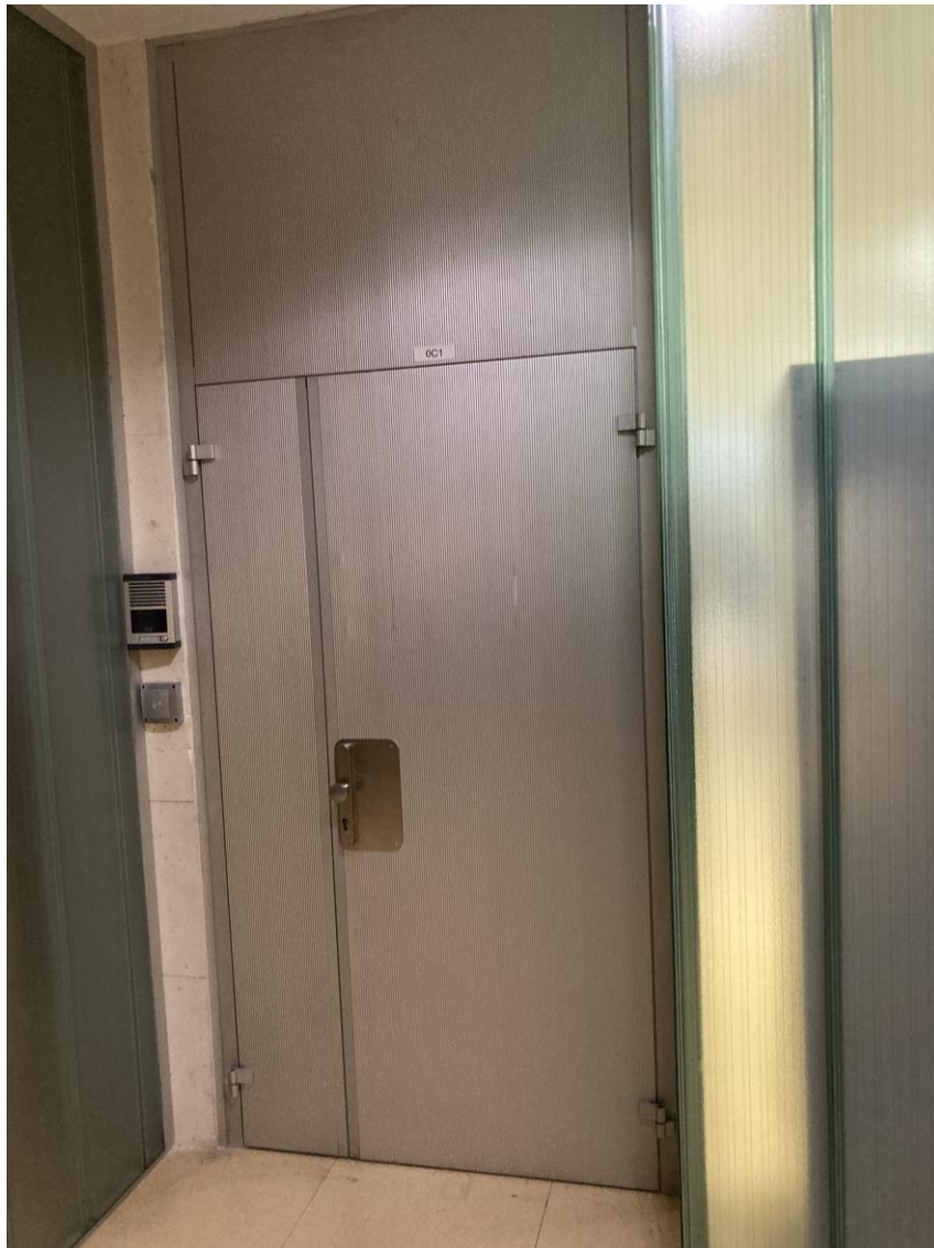
Puerta de entrada a la sala de operación
