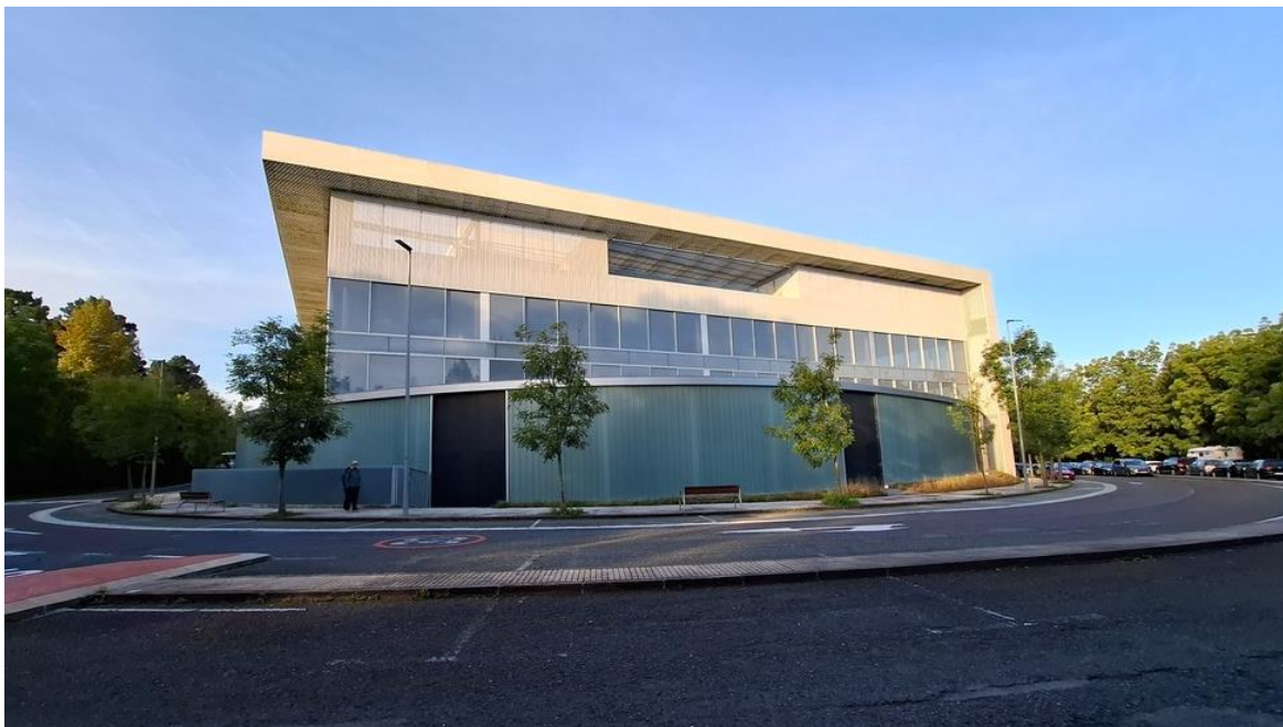
Fachada principal edificio A22
