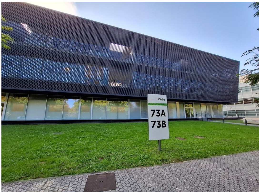
Fachada principal edificio A21
