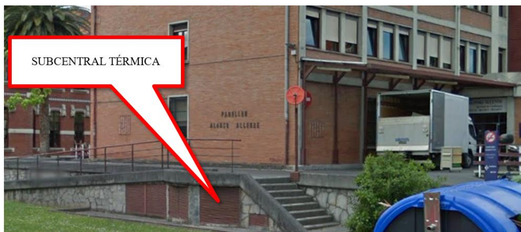
BAJO RAMPA ACCESO: HEMODINÁMICA.
